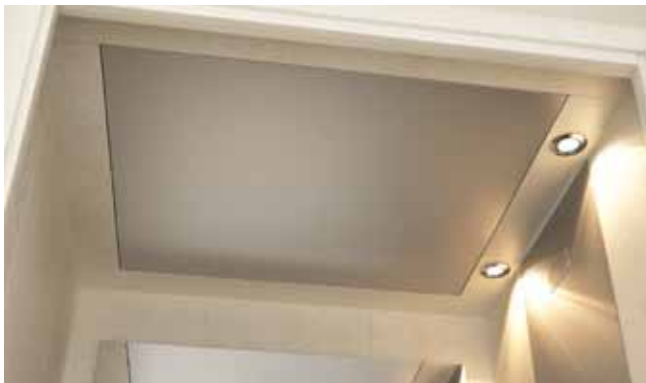
Techo de la cabina con dos focos
